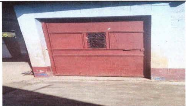
Foto1: Cambio de chapa y pintura de puerta.
