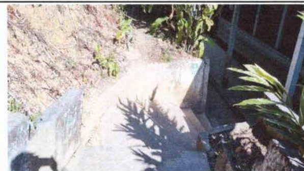
Foto 6: Remodelación de muros.
